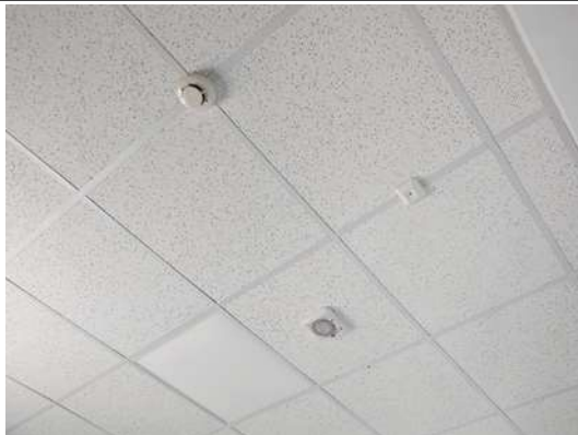
Foto Nr. 5.3.2.1. Informatīva bilde – UATS sistēmas detektors ar papildus detektoru aiz (virs) piekaramiem griestiem ar iznesamo indikatoru. UATS sistēmas detektors nav nomarkēts.
