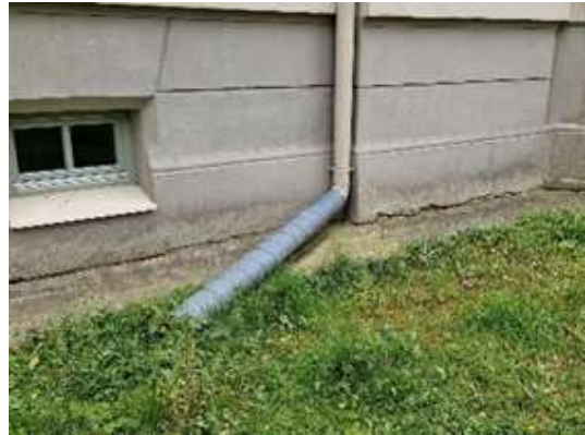
Foto Nr. 4.1.6. Bojāta cokola apdare
