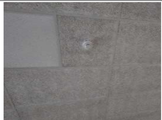
Foto Nr. 5.3.2.4. UATS sistēmas detektors nav nomarkēts; aiz (virs) piekaramiem griestiem nav uzstādīts papildus detektoru ar iznesamo indikatoru.
