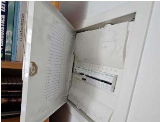
Foto Nr. 5.2.4.1. Sadalnes iekšpusē trūkst principiālās elektriskās shēmas.
