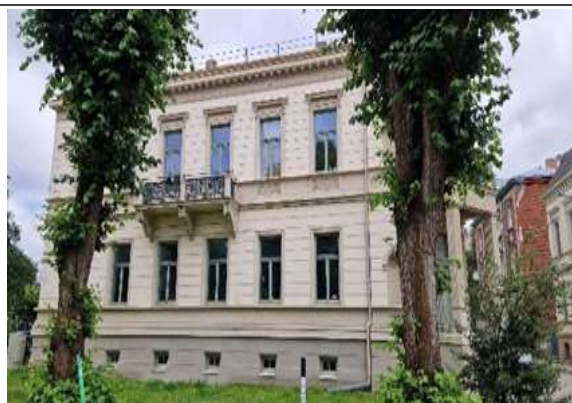
Foto Nr. 4.7.1.4. Ziemeļu fasāde (galvenā)
